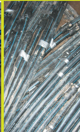
Die Erdsonden werden gesetzt
